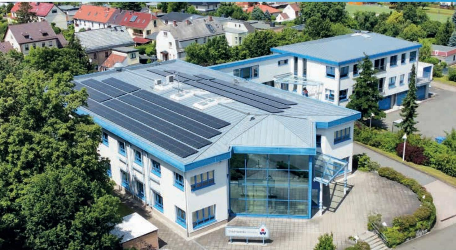
Die neue Solaranlage auf dem Dach des Firmengebäudes der Stadtwerke Werdau ist in Betrieb gegangen. Mit jährlich knapp 70.000 kWh erzeugtem Strom deckt sie rund 40 Prozent des Eigenbedarfs im Haus ab. Der überschüssige Strom fließt direkt ins öffentliche Netz und kann dort Strom aus fossilen Brennstoffen ersetzen. Von diesem Mehrertrag für Umwelt und Klima profitieren letztlich alle.
